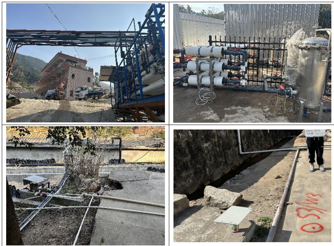
图 4.1.2-1 地上管道现场踏勘情况
