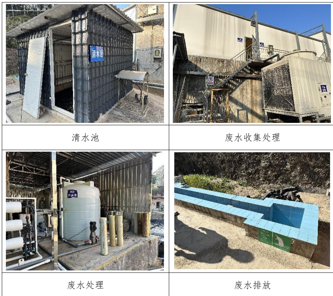
图 4.1.5-1 废水排放系统现场踏勘情况
