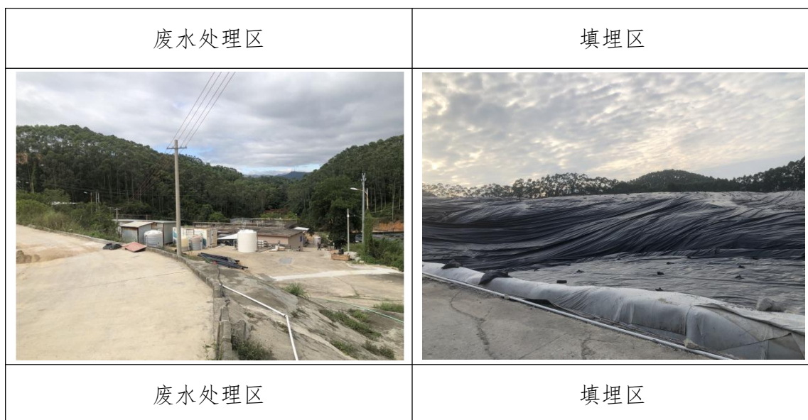
图 4.1.4-1 生产区现场踏勘情况
