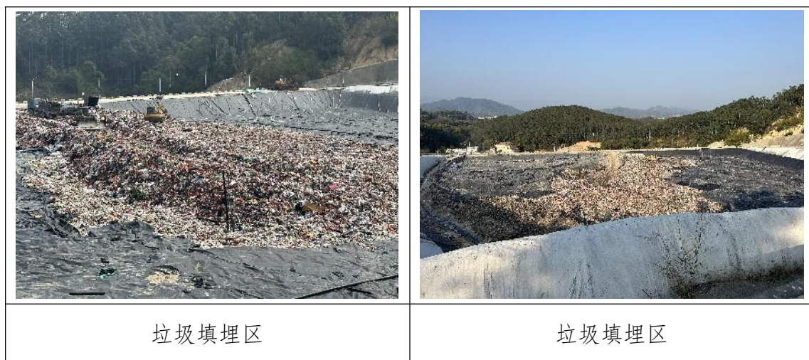
图 4.1.3-1 垃圾倾倒现场踏勘情况
