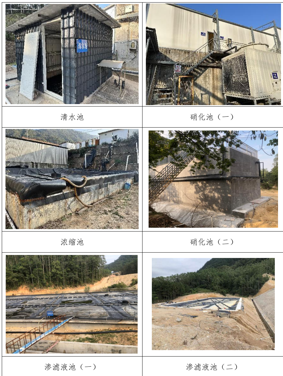
图 4.1.1-2 池体类设施现场踏勘情况
