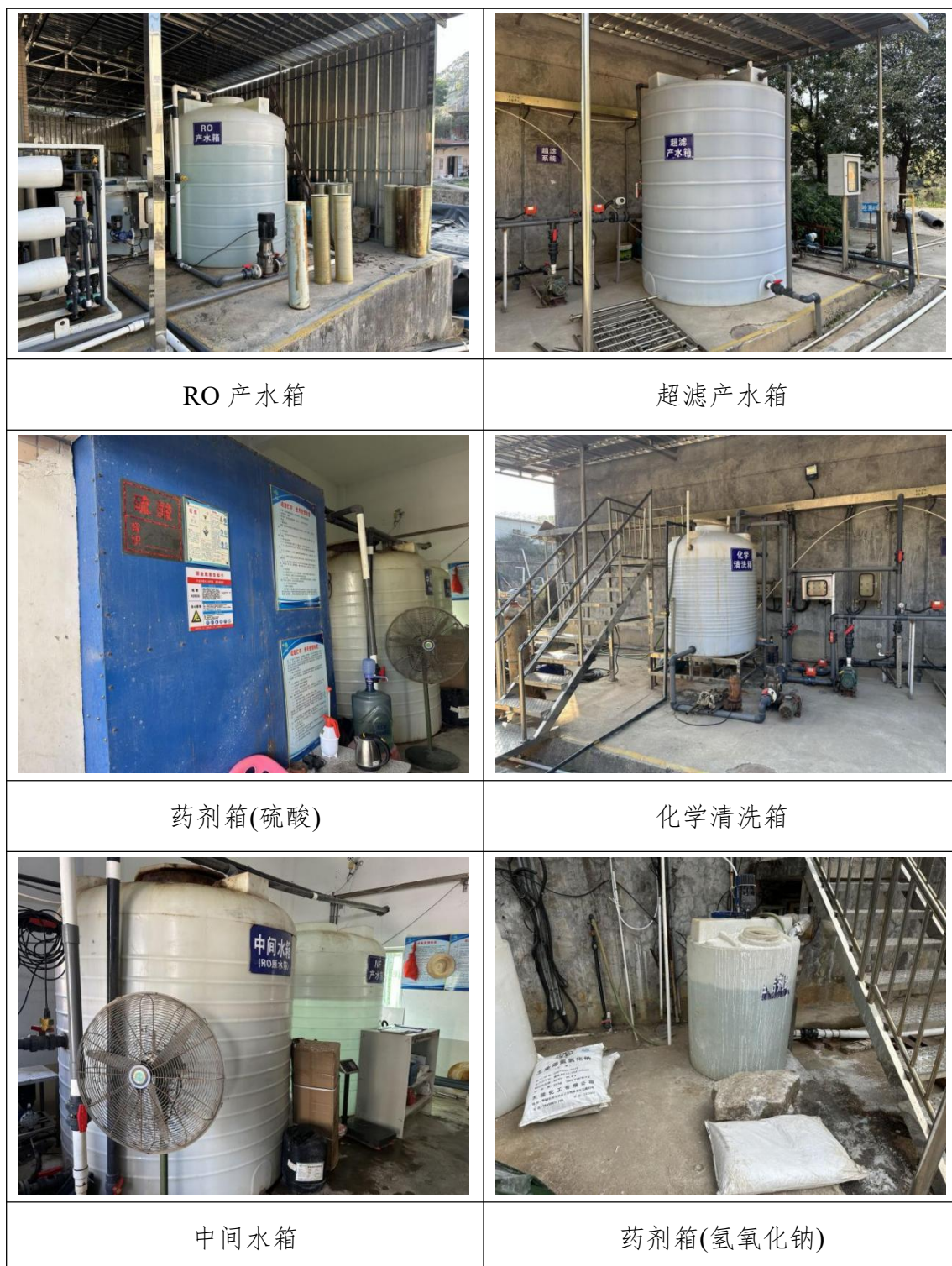
图 4.1.1-1 接地储罐现场踏勘情况
